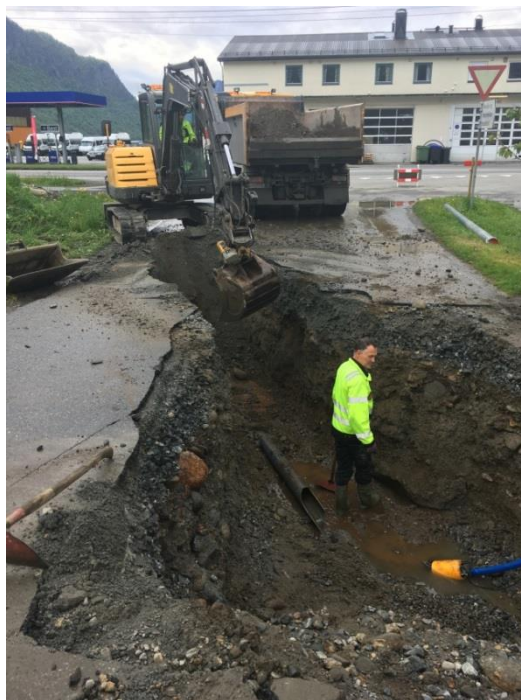
Utbetring av vasslekkasje ved Andersgarden
