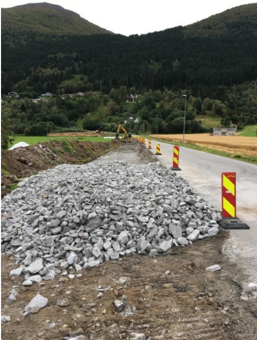
Bygging av nytt fortau til Vinjehjellane
